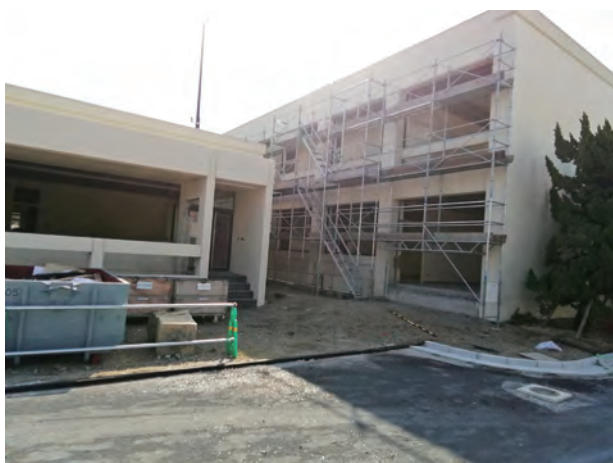
改修中の研究棟
