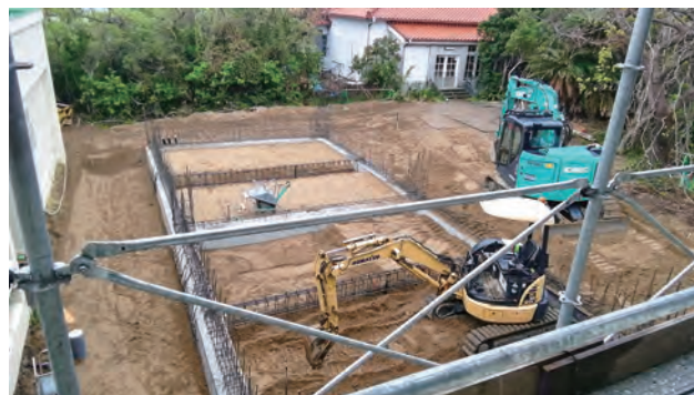
新研究棟の基礎工事
