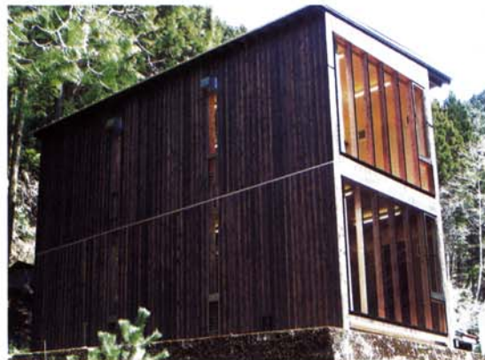
和歌山研究林 j.Pod 教育研究棟全景
