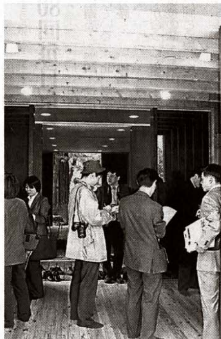
モデルハウスの内部。天井が板材で作った枠を連ねて出来上がっているのが分かる
