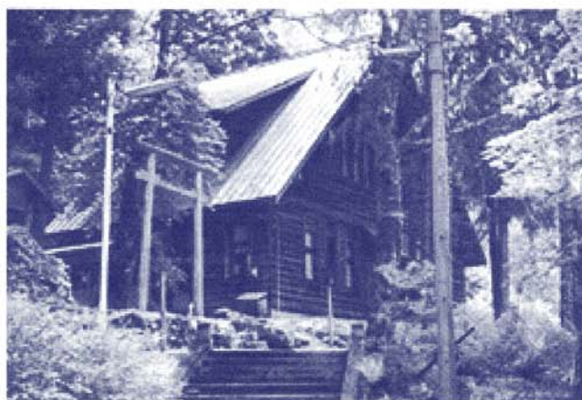
事務所の建物
