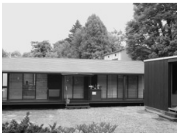
京都大学フレーム構法（仮称）による連携研究推進棟
