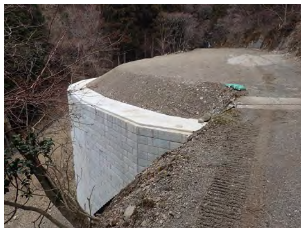
復旧された10林班土場
