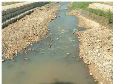
野田川中流。左岸はサンドバック、川底は土石流が運んだ礫と砂。これから重機が流す。
