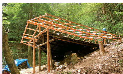
炭焼き窯の屋根新設作業 （上賀茂試験地）
