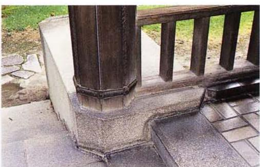
►心地よい風が通るベランダの天井の意匠には、モダニズムの息吹きが感じられる。ベランダの柱はギリシャや唐招提寺のような円柱ではなく、角柱で力強さを表現し、さらに鉄で補強している
