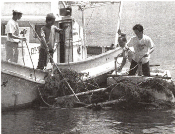
間伐材魚礁の設置作業
