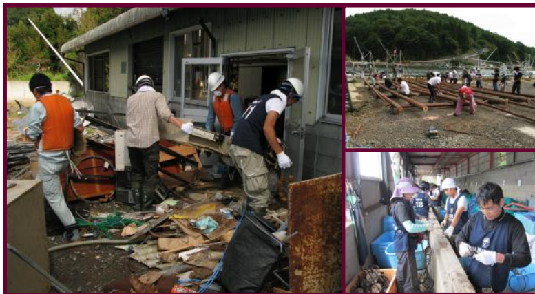
写真左：瓦礫撤去作業 写真右上：牡蠣養殖筏の製作 写真右下：筏に吊すロープに種牡蠣のついた帆立貝の殻を固定
