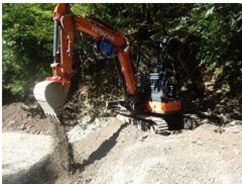
「ミニ油圧ショベルの操作の様子」
