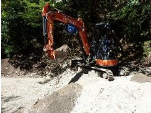
「ショベルで土をすくっている」
