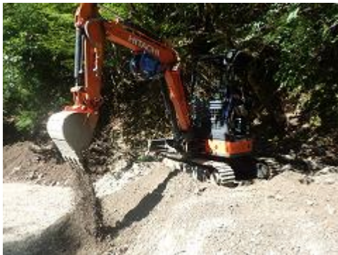
「ミニ油圧ショベルの操作」
