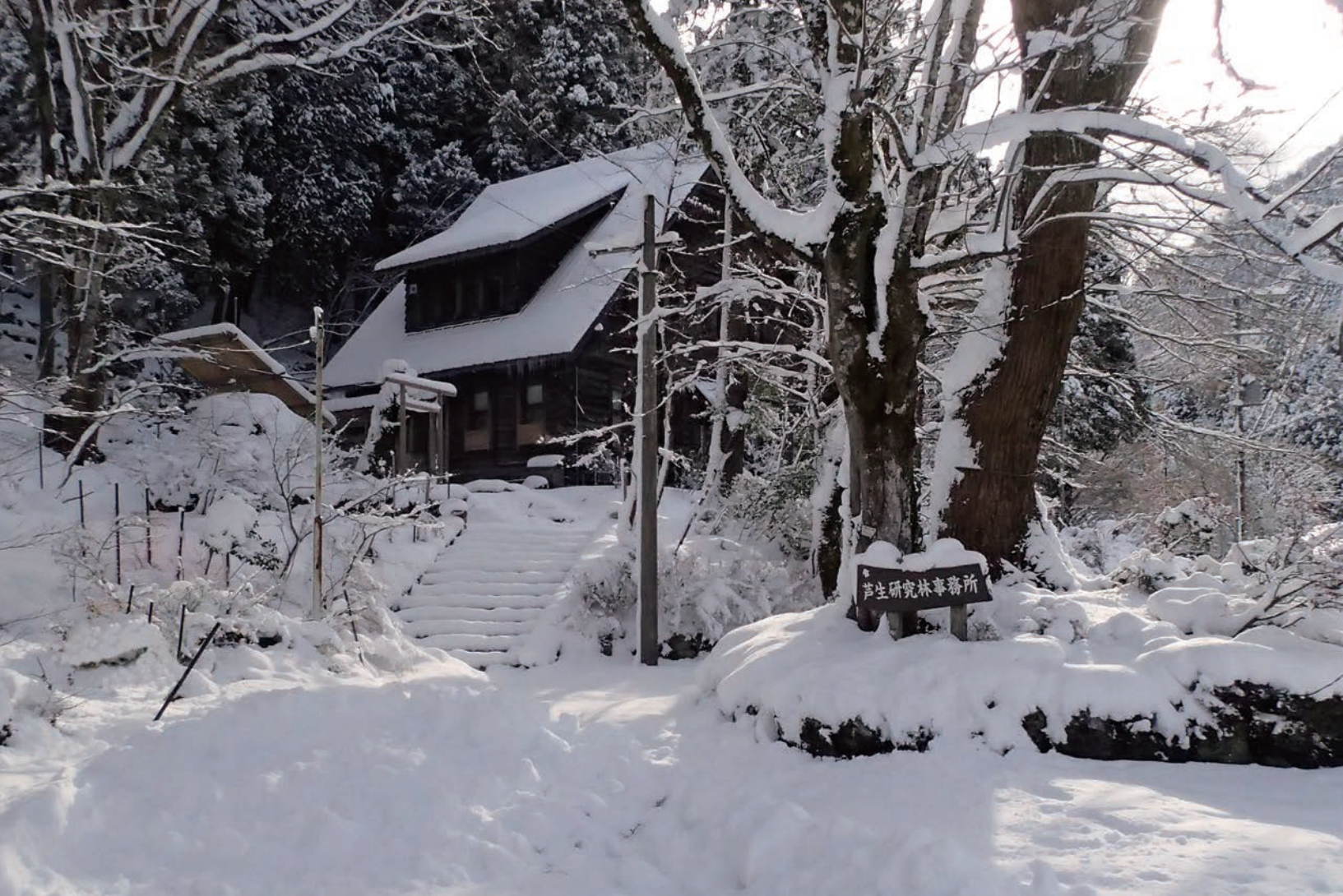
1931 年築の事務所棟 Office built in 1931.
